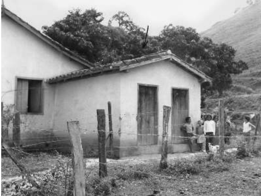
Escola Estadual Não Pensei
