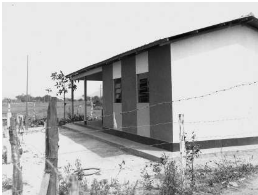
Escola Estadual Não Pensei
